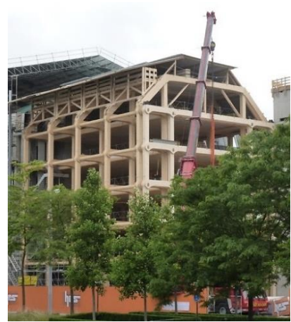
Fig. 62. Fase de estructura durante la construcción del edificio Tamedia Building en Zúrich. Fuente: https://cutt.ly/QmuFfs5
