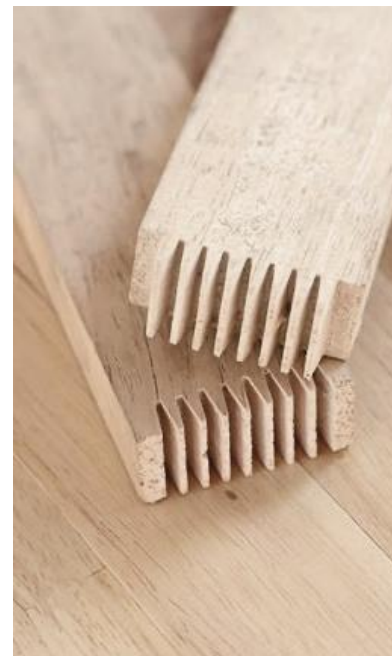
Fig. 60. Empalme mediante uniones dentadas o a peine ( finger joints ). Fuente: https://cutt.ly/Emc7qlp
