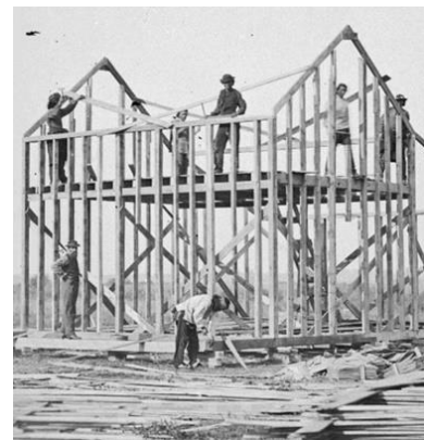
Fig. 16. Montaje de la estructura ligera según el sistema de globo en Estados Unidos. Fuente: https://cutt.ly/BmzdVlv
