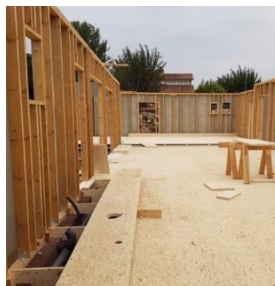
Fig. 86. Fotografía de una obra durante la fase de estructura, empleando montantes del producto estructural LSL. Fuente: https://woodify.es/producto/lignumstrand-lsl/
