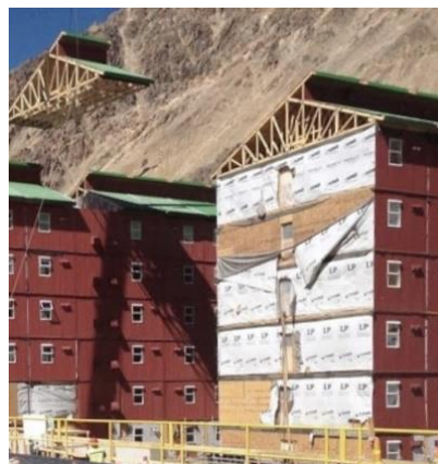
Fig. 65. Construcción del Campamento minero Pérez Caldera – Los Bronces, en Chile (2018). Fuente: https://asap.cl/soluciones/nuevo-campamentot-los-bronces/
