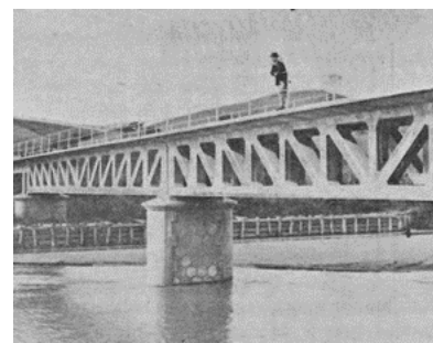
Fig. 47. Puente sobre el río Vélez en 1909. Fuente: http://ingenieriacivil.cedex.es/index.php/ingenieria-civil/article/view/2402
