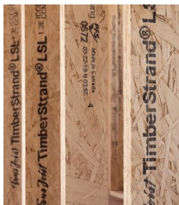
Fig. 85. Montantes LSL como estructura de un sistema de entramado ligero. Fuente: https://cutt.ly/wmug3z5
