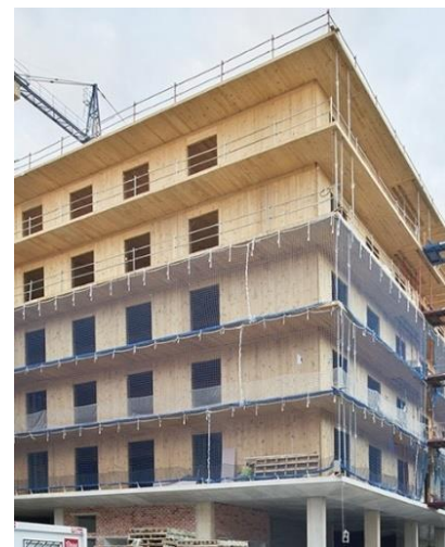
Fig. 71. Fase de construcción del edificio de 85 viviendas en Cornellá, Barcelona. Fuente: https://cutt.ly/gmoYcmU
