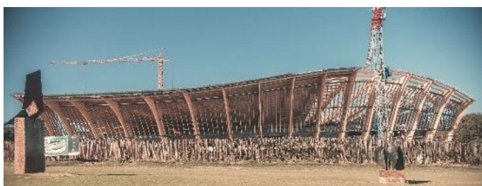
Fig. 74. Fotografía interior de la estructura de GLT de frondosa en el Museo de Arte Contemporáneo Americano. Fuente: equipo de ingenieros estructurales en madera de Oak Ingeniería.
