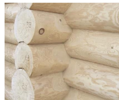
Fig. 07. Detalle de la junta de la cabaña de troncos. Fuente: https://cutt.ly/vmlIA3z
