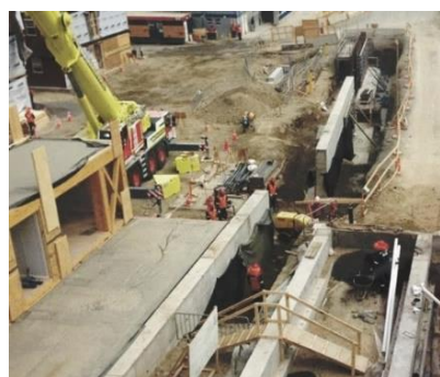
Fig. 66. Cimentación del Campamento minero Pérez Caldera, en Chile. Fuente: https://asap.cl/soluciones/nuevo-campamentot-los-bronces/
