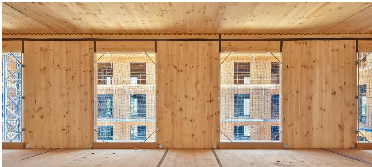
Fig. 105. Forjado de CLT en el edificio de 62 VPO de Cornellá. Fuente: José Evia.
