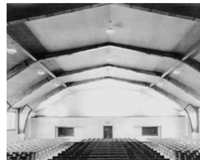
Fig. 57. Estructura con vigas en arcos lamiados encolados en el gimnasio de Peshtigio, Wisconsin Fuente: Forestal y Maderero ( https://cutt.ly/fmtPjiv ).
