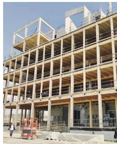
Fig. 63. Fase de estructura durante la construcción del edificio Office Perspective en Burdeos, Francia. Fuente: https://cutt.ly/cmuGqBp
